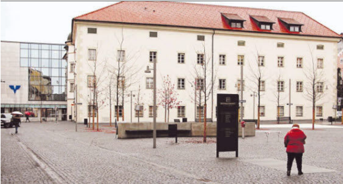
Rathausplatz in Spittal: Beeinträchtigte üben Kritik an der Bauausführung KARI (2)
