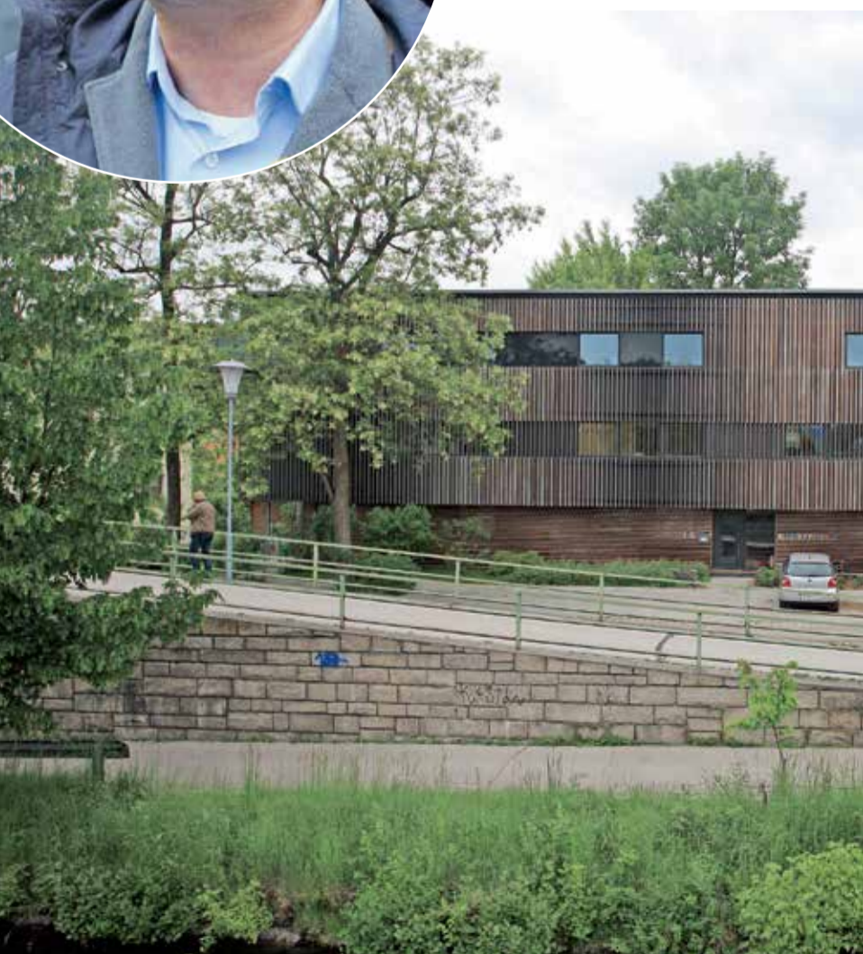
■ Poslovna stavba je le 20 metrov oddaljena od ene glavnih celovških prometnic in pred hrupom stanovanj, ki stoji za njo.
